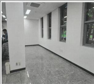
지상1층 공사 후
